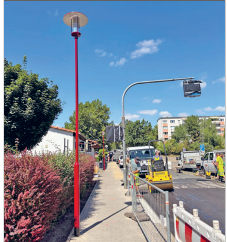
Sanierungsarbeiten am FGÜ Busplatz
