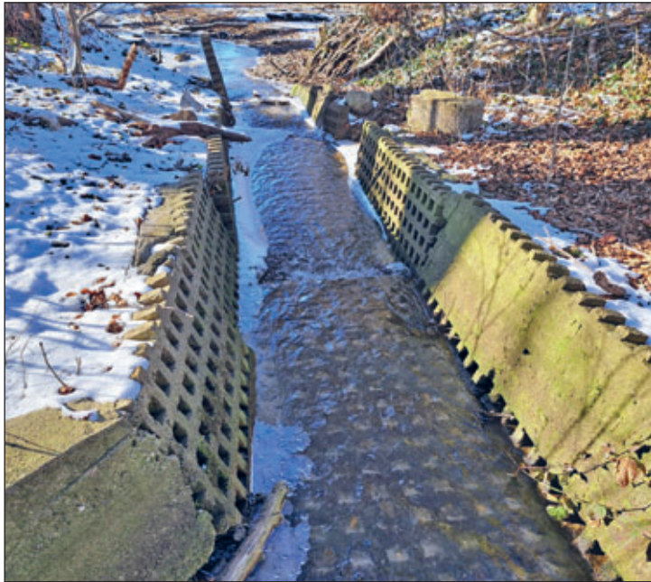
Ein mit Rasengittersteinen verbautes Gewässer. Die Platten sind instabil und im Hintergrund kann man sehen, wie sie bereits ins Gewässer fallen. Zurück bleibt ein ungeschütztes Ufer. Foto: Wetzelt, LfULG
