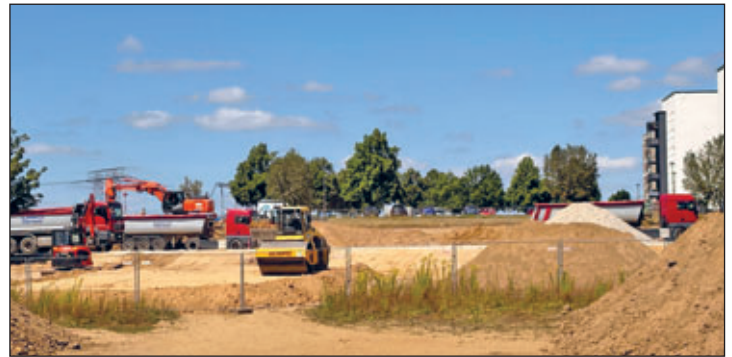
Blick auf das EDEKA - Baufeld an der Leipziger Straße
