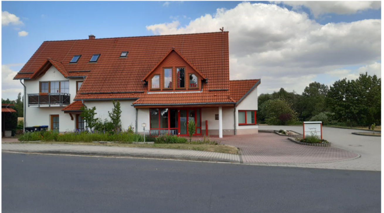
Abbildung: Feuerwache der Freiwilligen Feuerwehr Kitzscher an der Leipziger Straße mit Immissionsbereichen IP4 und IP5
