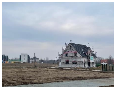
Baustelle neues Wohngebiet, Leipziger Straße
