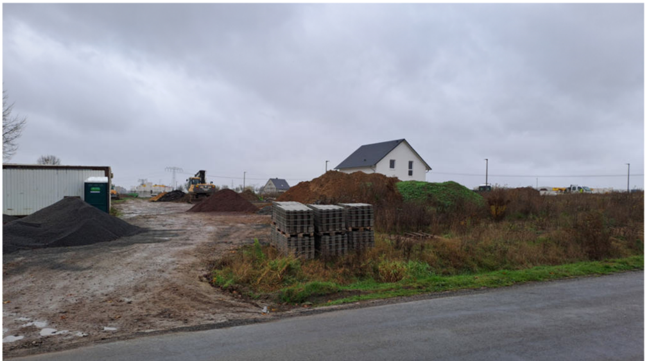
Abbildung: Immissionsbereich IP1 und IP8 (Baufeld WA5 des B-Plans „Leipziger Straße“) mit bereits im Bau befindlichen Wohnhäusern (Stand 11/2024)
