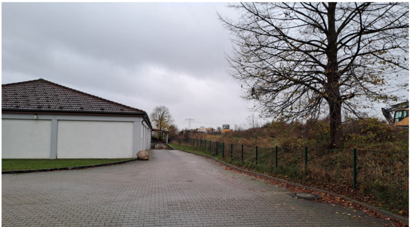
Abbildung: Anlieferbereich Sonderposten-Markt im Bestand mit Böschungskante zum rechts gelegenen Baufeld WA5 des B-Plans „Leipziger Straße“
