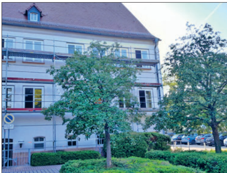
Gerüstbau am Rathaus
