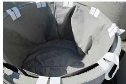
Nicht befestigter Filtersack in einem Schachtring DN 150/100 cm
