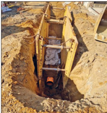
die Grundstücke mit Pflaster angepasst werden. So sah es noch Anfang Oktober in der Bäckerstraße bei der Verlegung des Mischwasserkanals aus, aktuell stehen die Tiefbauarbeiten vor dem Abschluss und der Asphaltbau kurz bevor.
