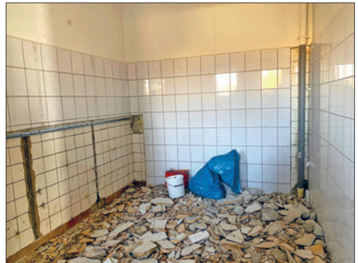
Abriss der bestehenden Anlagen in der OSK
