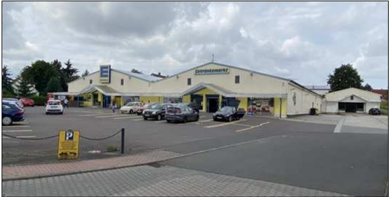
Blick auf den derzeitigen EDEKA Bestandmarkt an der Bornaer Straße 25
