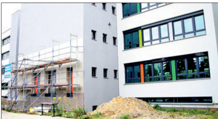
Fortschritt der Sanierung des neuen Haupteinganges
