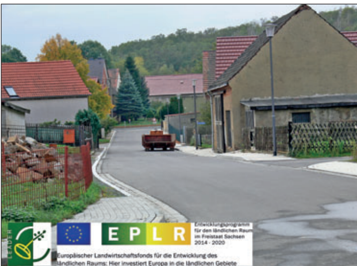
Mit dem Blick in die Rohrbacher Straße ist die neue Straßenbeleuchtung zu sehen
