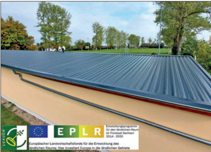
Das Sportlerheim in Hainichen – nach Fertigstellung der Dachsanierung mit Blick über das gesamte Sportplatzgelände
