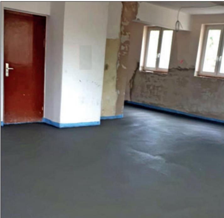
Der Fußboden wurde am 03.09.2020 neu mit Estrich ausgegossen
