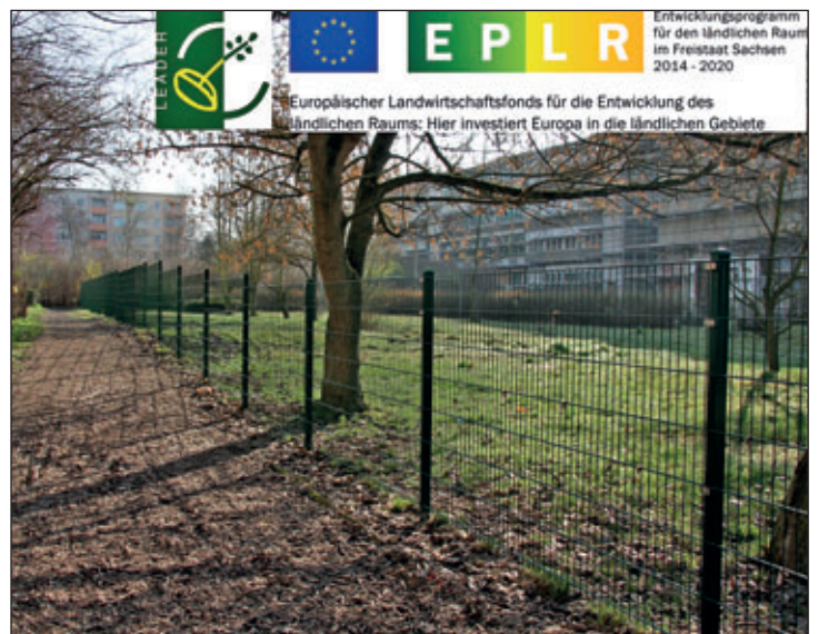
Erneuerung der Zaunanlage rund um das Oberschulgelände abgeschlossen
